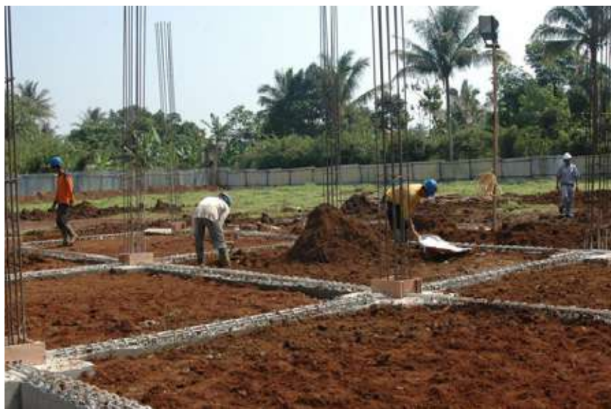
Tahap pembangunan pondasi
